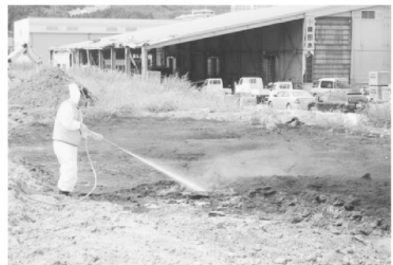
写真1 魚類埋設場所
