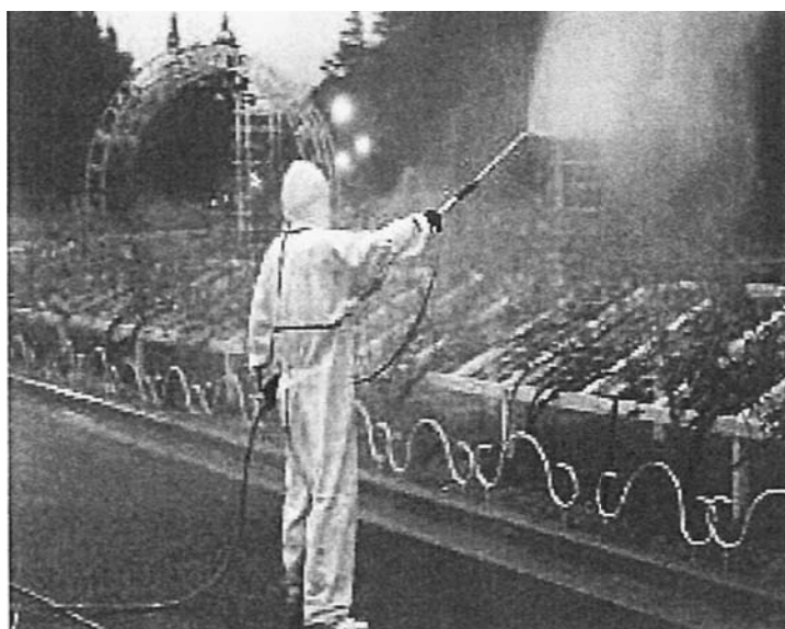
動力噴霧機による作業
