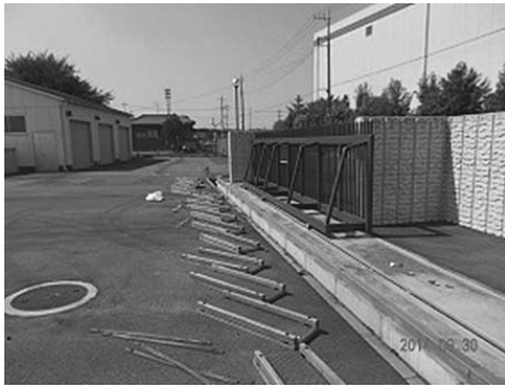
作業場所の一部
