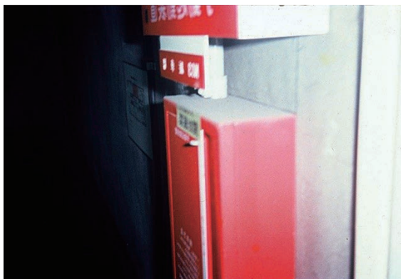
図2 スイッチ盤ボックス
