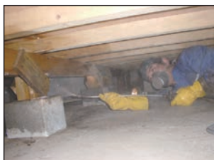
床下木材に薬剤吹付け
