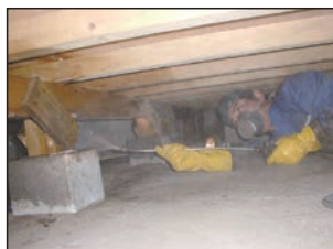
床下木材に薬剤吹付け
